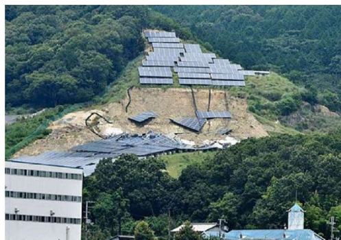
法面崩壊による施設の崩落
