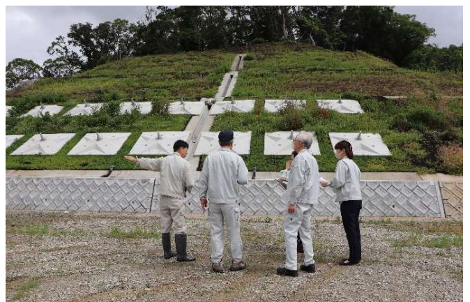
(篠栗北地区産業団地事業用地2法面工事監査)
