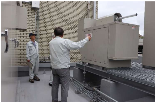
(庁舎非常用電源等電気設備改修工事監査)
