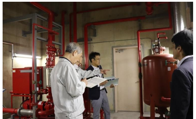
(総合保健福祉センター地下駐車場泡消火設備改修工事監査)
