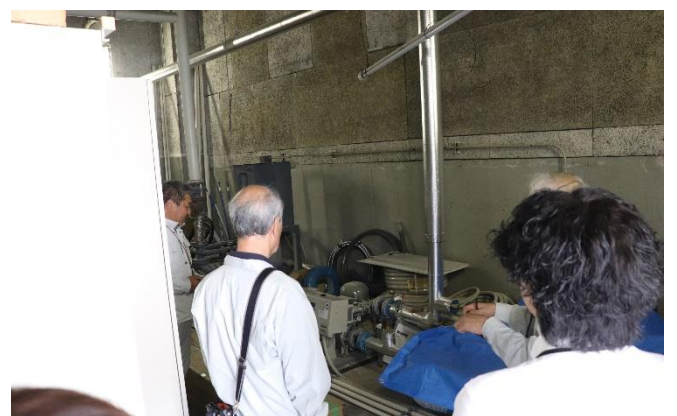
(庁舎給水設備等機械設備改修工事監査)
