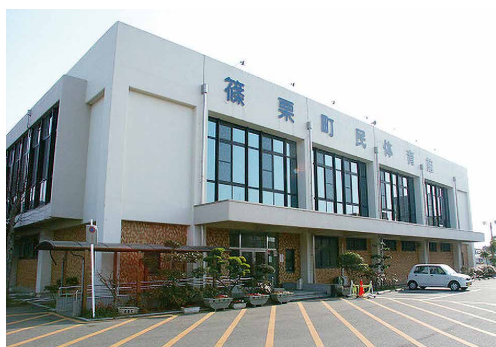
現在利用を停止している町民体育館
