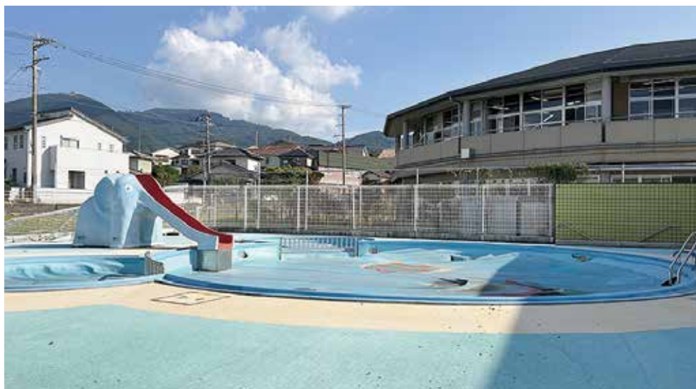
解体予定の勢門幼児プール
