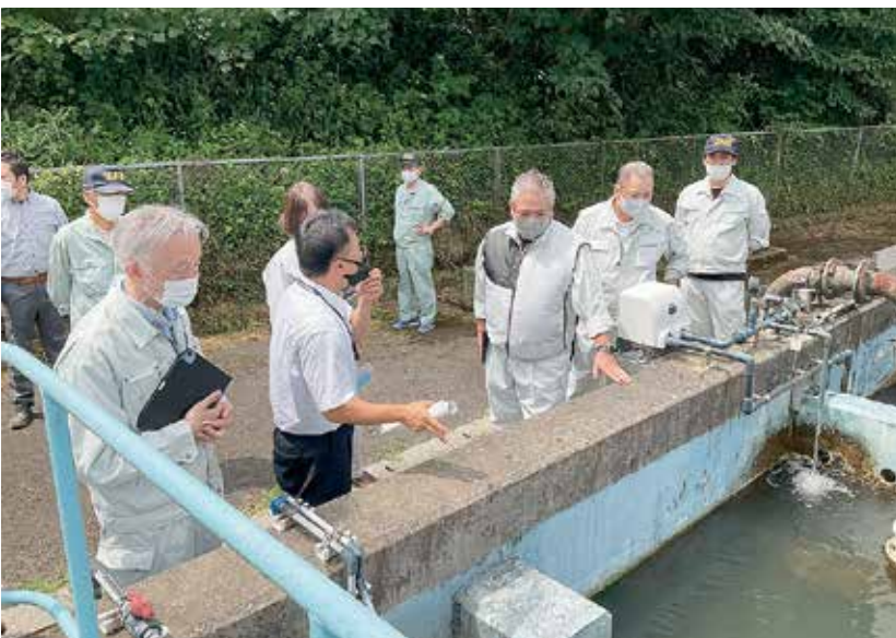
第一浄水場を視察(自家用発電機更新工事)
