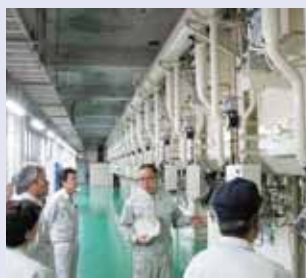
北筑昇華苑にて機械設備の説明を受ける
