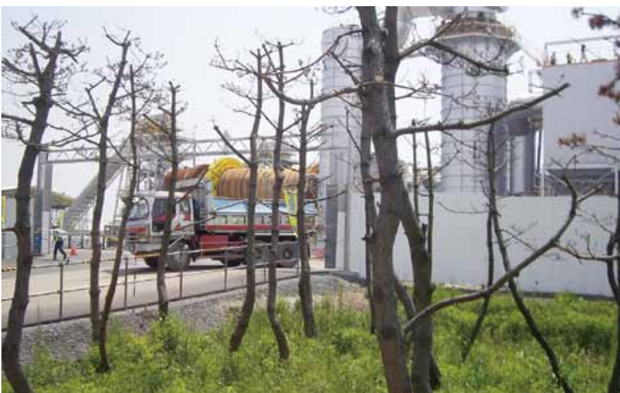
がれき焼却施設（石巻市）
