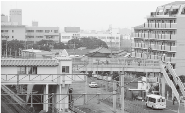
篠栗駅 跨線橋
