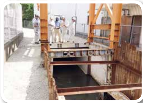
▲尾仲乙犬地区水路改修工事 (4382万円) 水浸被害を軽減するための水路改修工事。
