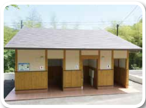
▲桐ノ木谷公衆トイレ建築工事 (2797万円) 循環型水洗トイレで、 かきから 蠣殻バイオマスを使用。
