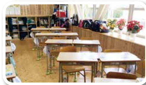
▲篠栗中学校普通教室内装木質化工事(7教室) (1280万円) 地元篠栗産の杉・桧材を加工した板材を使用した教室内装木質化工事。
