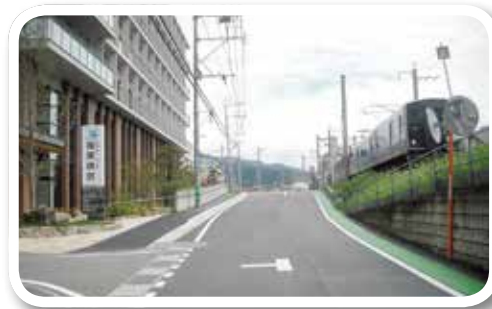
▲中町津波黒道路改良工事 (1099万円) 渋滞の緩和や安全性を高める道路改良工事。 平成27年7月末完了。
