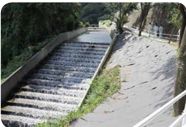
西浦川河川維持工事（1534万円） 樹木伐採工事
