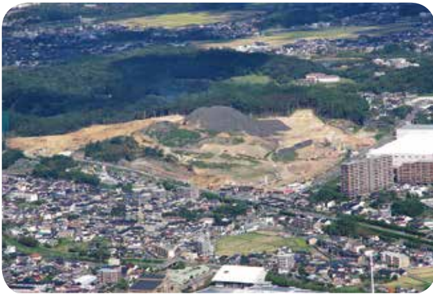
篠栗北地区産業団地整備事業（継続中） （1億5249万円）※金額は29年度の決算額 写真は造成工事の様子
