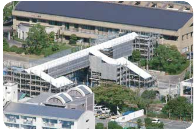
篠栗駅東側自由通路新設工事（継続中） （3億6524万円）※金額は29年度の決算額 平成31年1月に開通予定。
