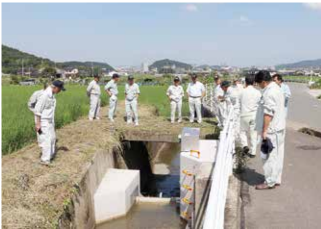
乙犬地区井堰改修工事現場
