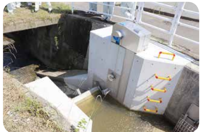
乙犬地区井堰改修工事（2033万円）
