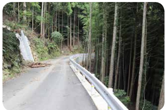
山手郷の原線改良工事（2407万円） 舗装補修工事
