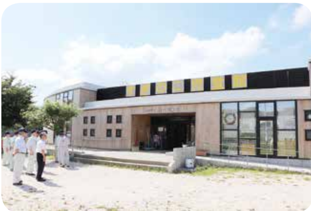
すぎのこ児童館外壁及び屋根改修工事（2505万円） 外壁腐敗および屋根雨漏りの大規模修繕
