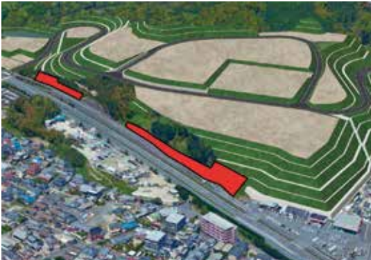
■ 津波黒地区法面補強工事箇所
