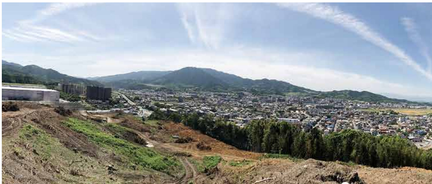
篠栗北地区産業団地造成工事
