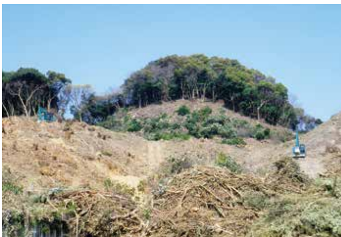
造成工事の様子
