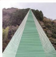
⑫鳴洲ダムの管理棟 (屋根部分)
